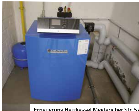
Erneuerung Heizkessel Meidericher Str. 57
