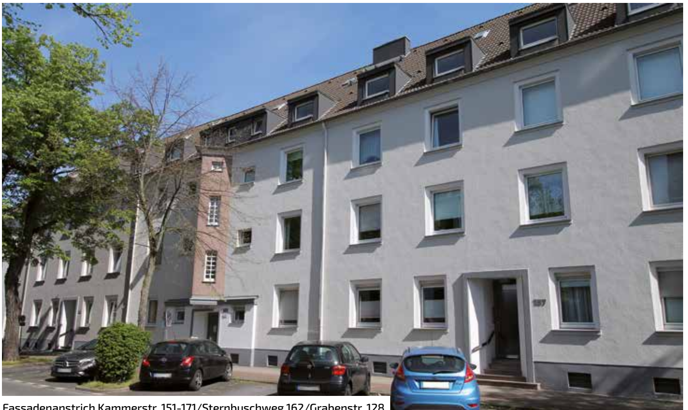
Fassadenanstrich Kammerstr. 151-171/Sternbuschweg 162/Grabenstr. 128
